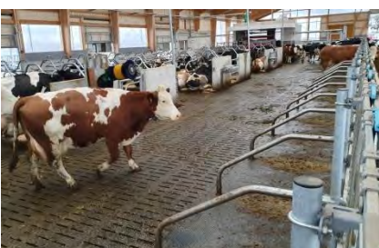
EIP-Neubau mit Kammaufstallung und kurzen Wegen zum Laufhof, erhöhten Fressständen und emissionsmindernden Spalten
